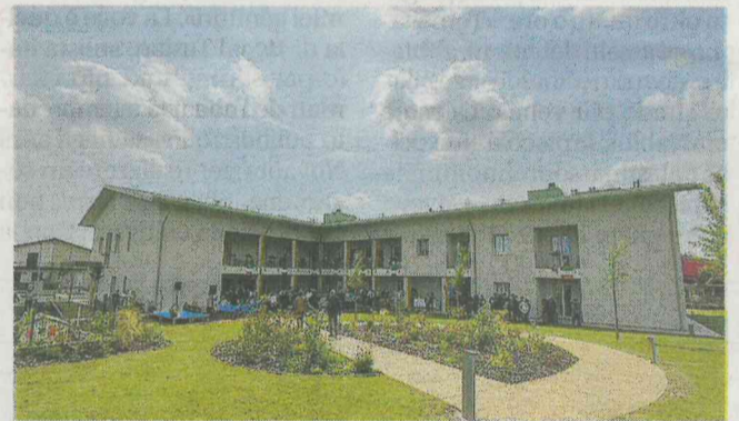
In via Violino di sopra. Due piani con alloggi e diversi servizi
