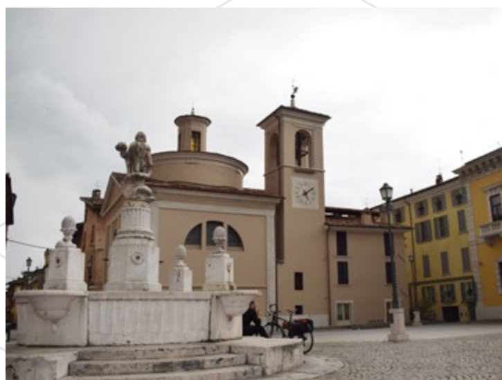
Il Complesso Madonna del lino al termine dei lavori di consolidamento e rifacimento del tetto e delle facciate
